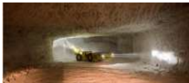
800 Meter unter Unterbreizbach: Mit Spezialgeräten wird nach einer Sprengung loses Gestein vom First gebrochen
